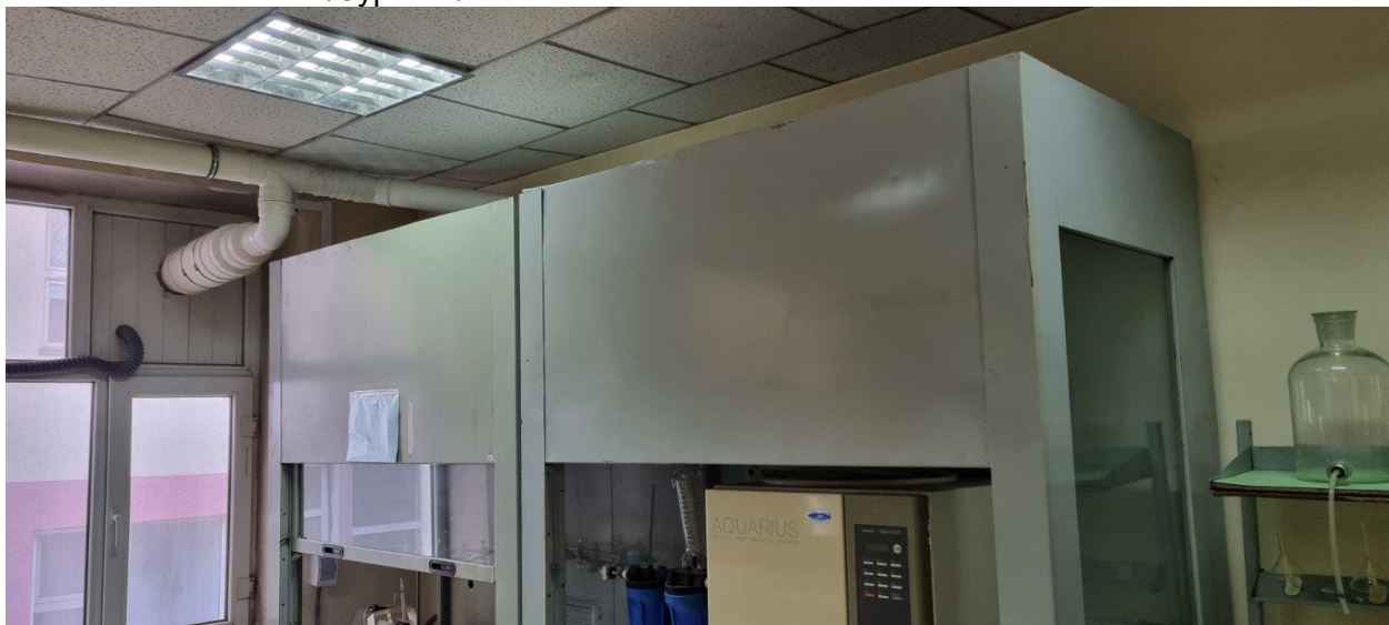
Зураг 2. Агаарын шинжилгээний лабораторид нэмэлт сорох шугам суурилуулсан байдал
