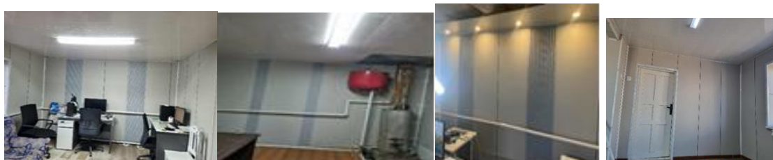
Зураг 2. Дунд ус өртөөний засварын ажил хийсэн нь
