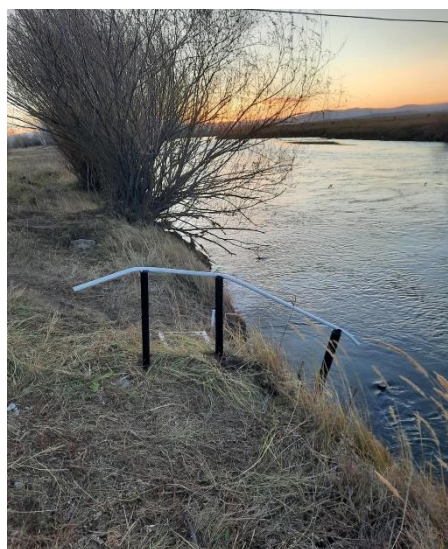
Зураг 2. Ажиглалтын цэг усны түвшин хэмжих эгц эрэгтэй хэсэгт төмөр бариултай шат хийж тохижуулсан
