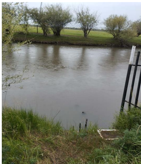
Зураг 2. Ажиглалтын цэг усны түвшин хэмжих эгц эрэгтэй хэсэгт төмөр бариултай шат хийж тохижуулсан
